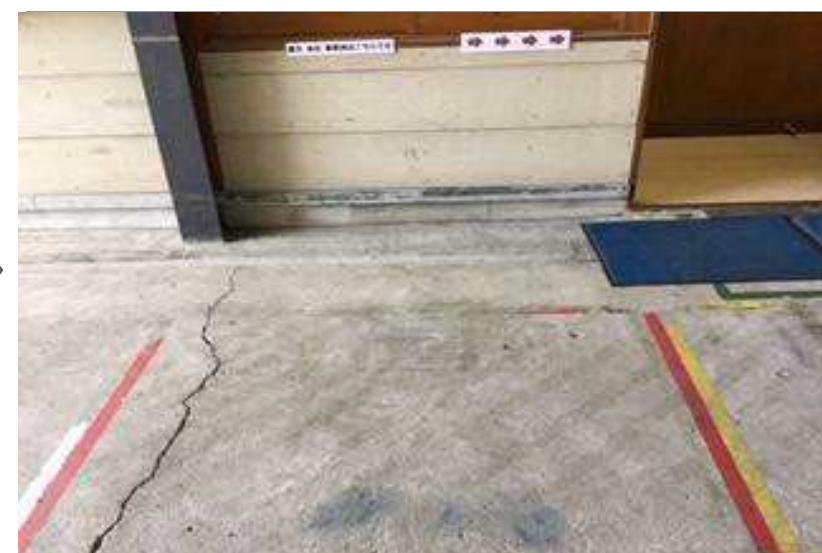
スクールSHOP入口。床のテープを剥がした後に接着剤が残り、靴底にねばねばが付着して不快なので除去しました。除光液と剥離剤を使用しました。
